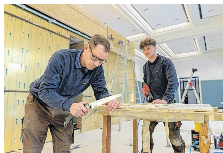
Stefan Seifert (links) und Lauren Fischer von der Holzwerkstatt Trommer bauen den Speisesaal der neuen Forstschule aus. Das ehemalige Casino beherbergt Speisesaal und Ausgabeküche, dazu Turnhalle und Aufenthaltsräume. Platz für eine vollwertige Küche war nicht. FOTO: DAVID RÖTZSCHKE
